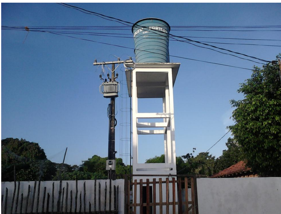
FOTO Nº 10 – SISTEMA DE ABASTECIMENTO DE ÁGUA DE BACURITEUA. Construído com verbas federais através do INCRA, vem atender a uma demanda antiga da população local da vila. (Foto: Elisamar Sousa 25/05/2012).
