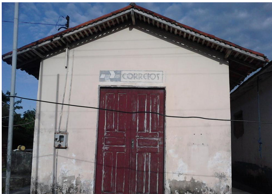
FOTO Nº 8 – AGÊNCIA DOS CORREIOS E TELÉGRAFOS DE BACURITEUA. A edificação construída pelo poder público municipal de Bragança, foi repassada a ECT, entretanto, pela falta de demanda dos serviços oferecidos pela mesma, logo deixou de funcionar. Na atualidade a mesma é utilizada como residência (Foto: Elisamar Sousa, 25/05/2012).
